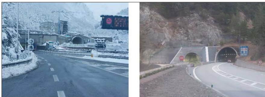
Figura 11 Tunnel del Frejus - Portali della seconda galleria in fase di costruzione
