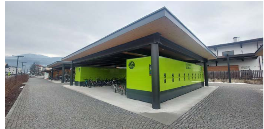
Figura 81 Velostazione per un Centro di Mobilità presso una Stazione ferroviaria (Brunico - Alto Adige)
